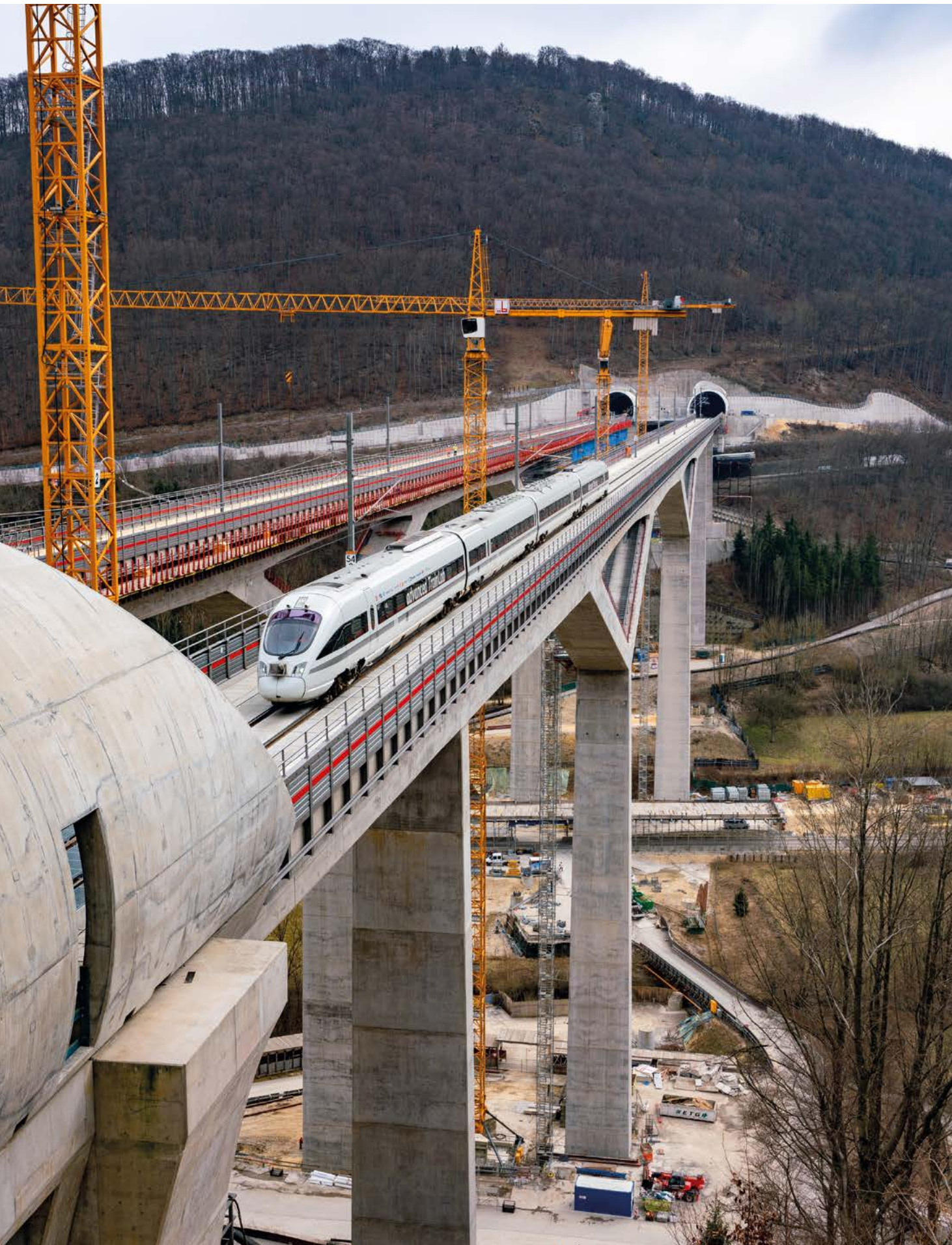
MESSZUG AUF DER FILSTALBRÜCKE
