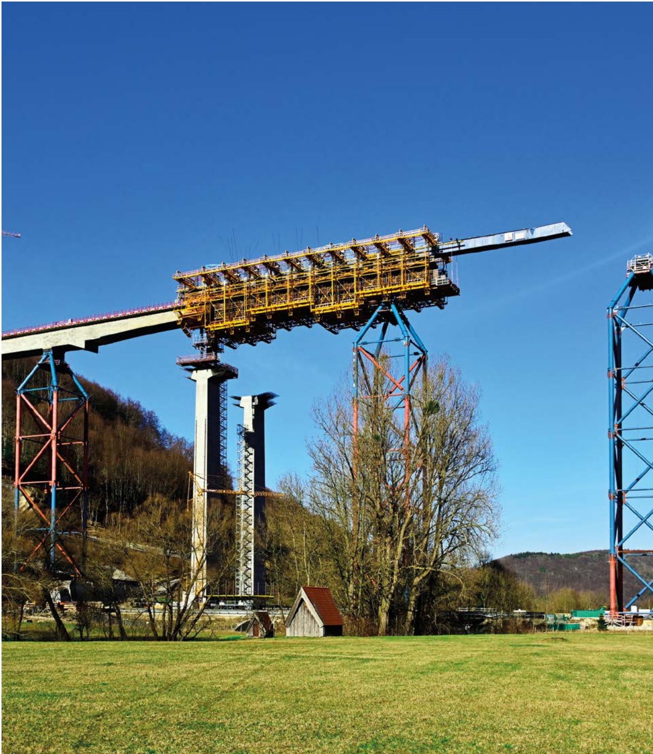
70 METER STAHLHILFSTÜTZEN mit Vorschubrüstung
