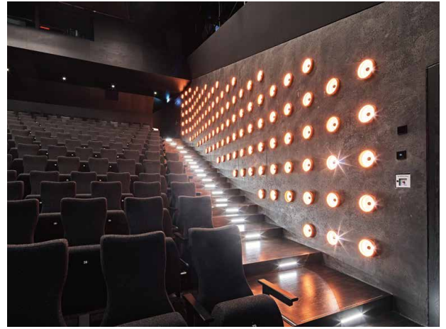
DETAIL ZUSCHAUERRAUM mit schallabsorbierenden Lichtelementen
