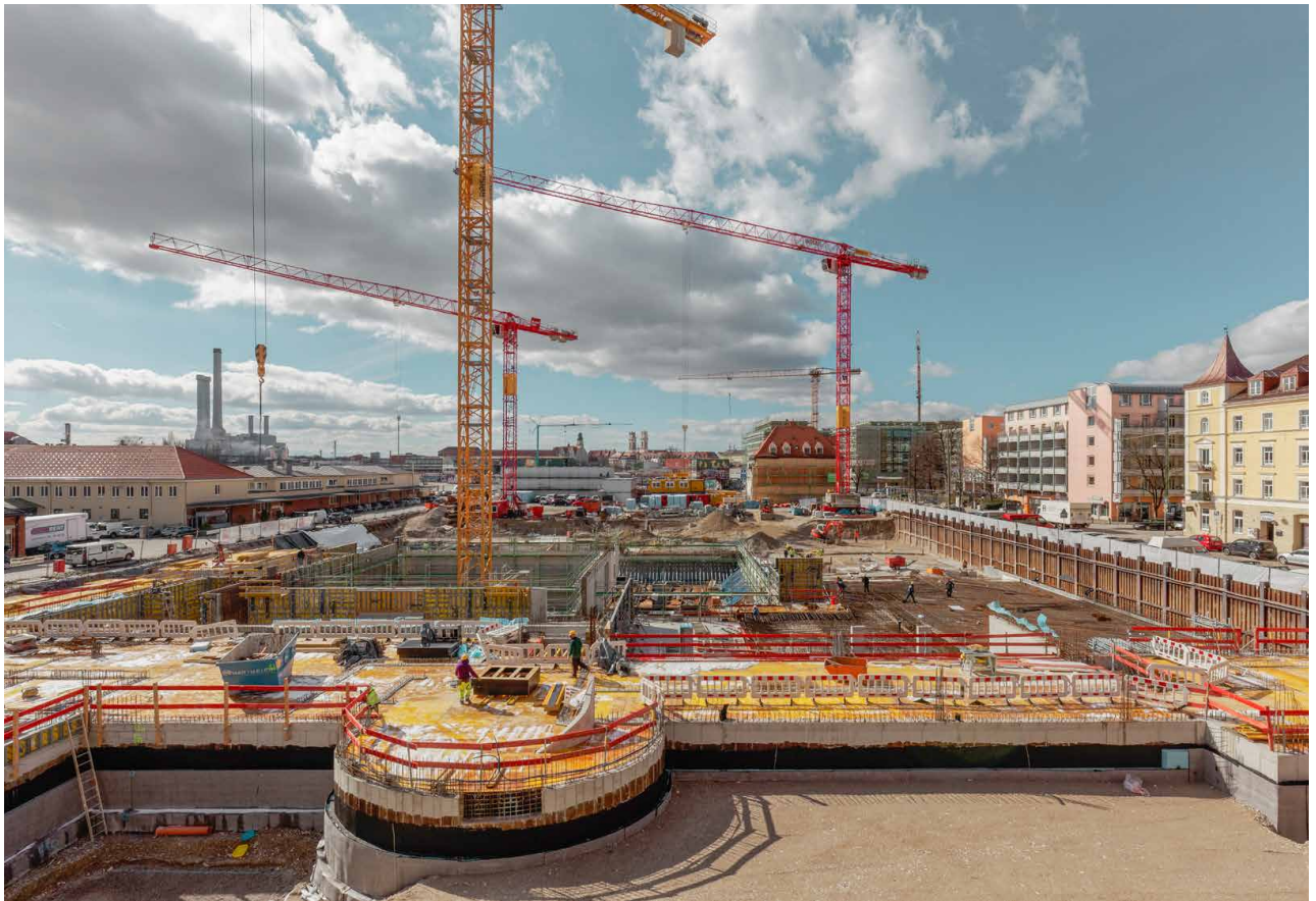
ARBEITEN AM KOMPLEXEN BAUPROJEKT AUF DEM EHEMALIGEN VIEHHOFGELÄNDE
