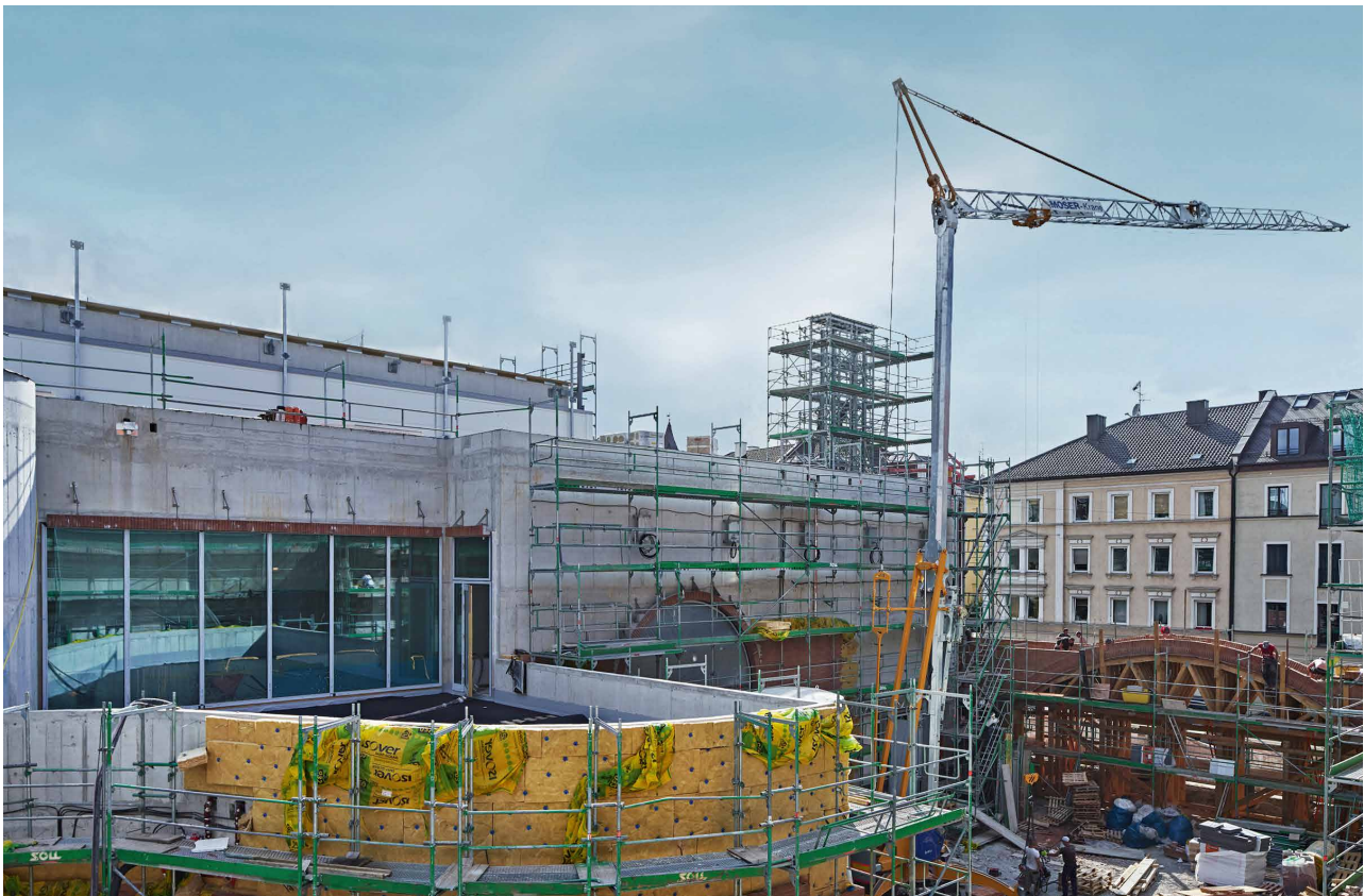
HAUPTINGANGSBEREICH AN DER TUMBLINGERSTRASSE gemauerter Bogen auf einem Lehrgerüst
