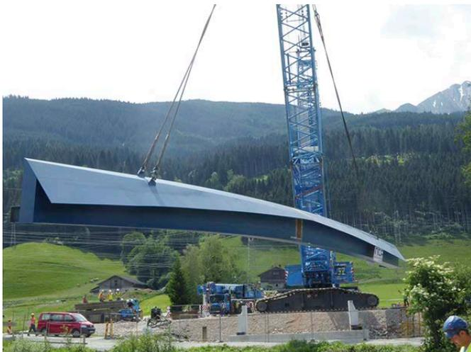
**Bild 12** Verlegen des 50 m langen Hauptträgers
