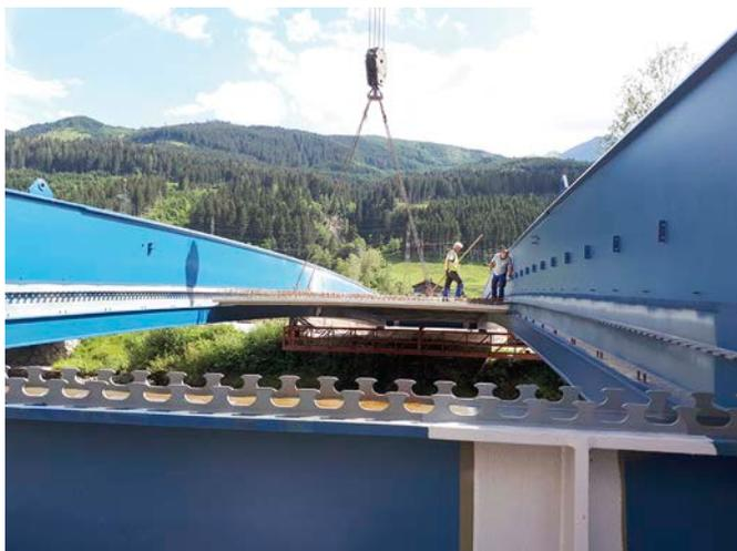
**Bild 15** Verlegen Fertigteilplatten
