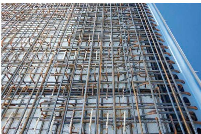
**Bild 16** Bewehrung der Fahrbahnplatte am Hauptträger
