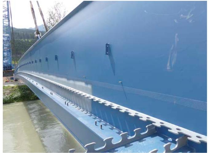
**Bild 13** Innenseite des Hauptträgers vor dem Verlegen der  $\pi$ -Platten
