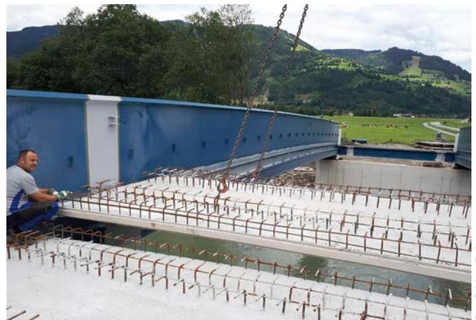
**Bild 14** Verlegen Fertigteilplatten
