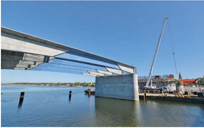
Bild 14. Verlegte VFT-WIB Träger (Foto: Grzegorz Mehring, gdansk.pl)
