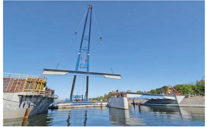
Bild 15. Verlegen des zweiten Feldes mit Schwimmkran vom Ponton aus (Foto: Grzegorz Mehring / Łukasz Ogrodziński, gdansk.pl)
