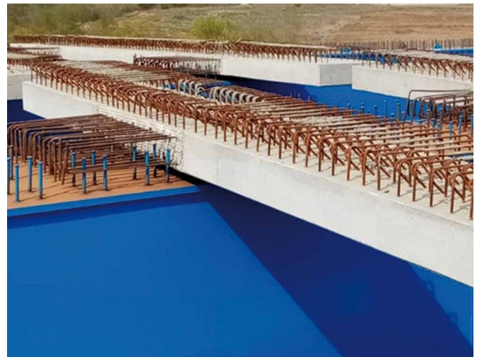
Bild 10 A 10 Sebeș-Turda Muresviadukt km 40 + 200: montierter Querträger A 10 Sebeș-Turda Mures viaduct km 40 + 200: mounted cross girder
