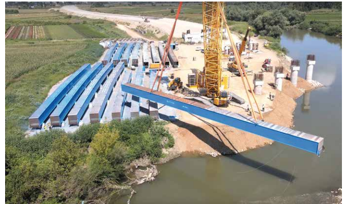
Bild 9 A 10 Sebeș-Turda Muresviadukt km 40 + 200: Verlegen eines 55 m langen gekrümmten Stahllängsträgers A 10 Sebeș-Turda Mures viaduct km 40 + 200: Transport of a 55 m long curved steel longitudinal beam
