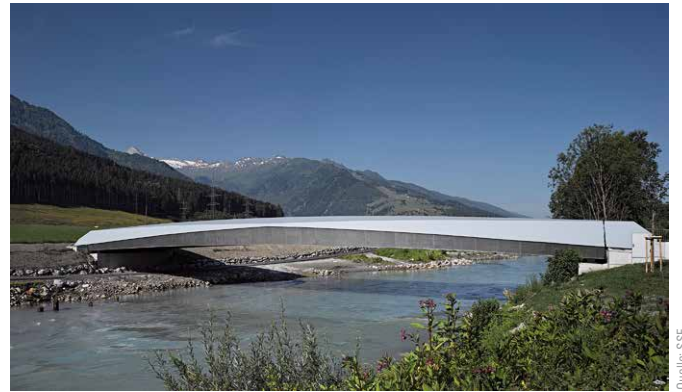
Bild 20 Beispiel für die Ansicht einer Stahlverbund-Trogbrücke (über die Salzach bei Kaprun) Example for the view of a trough bridge (over the Salzach river near Kaprun)
