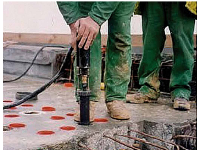
Bild 3 Aufschweißen der Kopfbolzendübel durch runde Öffnungen in den Fahrbahnplattensegmenten einer modularen Verbundbrücke in Frankreich [5] Welding of headed studs through round openings in the segments of a modular composite bridge in France
