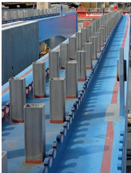
Bild 15. Stahlträger mit Arretierungen der Gleitbleche (© Max Bögl)
