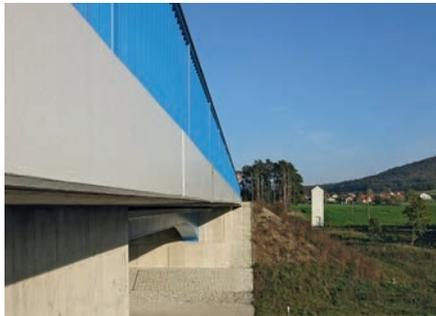
Bild 21. Kappenband des fertigen Überbaus (© SSF Ingenieure)
