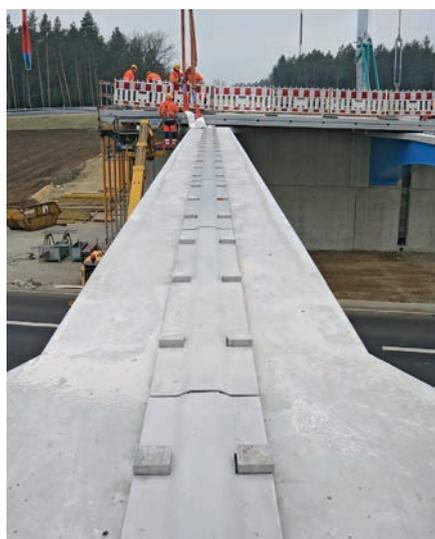
Bild 18. Edelstahlbleche auf dem Elastomerstreifen mit Arretierungen (© SSF Ingenieure)
