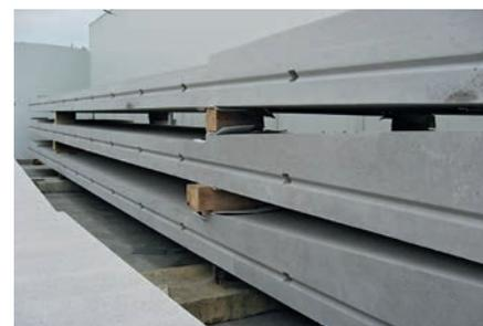
Bild 19. Stirnflächen der Fahrbahnsegmente (© Max Bögl)
