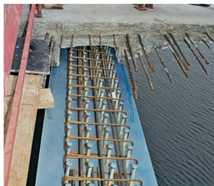
Bild 5. Fahrbahnplatte mit Verbundkanal, die auf zwei PTFE-Streifen gelagert ist (© SSF Ingenieure)
