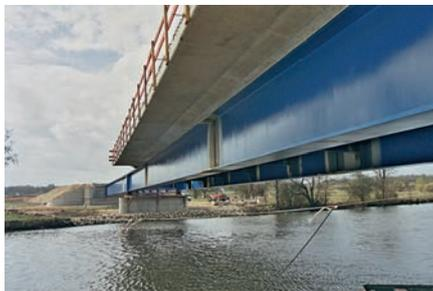
Bild 3. Viaduc de Vendôme/Loir, Bild der auf den Stahlträgern eingeschobenen Fahrbahnplatte aus Stahlbeton (© SSF Ingenieure)
