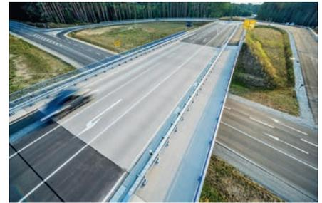
Bild 23. Brücke mit direkt befahrenen Segmenten aus der Vogelperspektive; der Übergang von der Asphalt- zur Betonfahrbahn ist gut zu erkennen (© Max Bögl)
