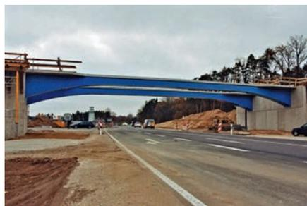
Bild 17. Rahmensystem als Haupttragwerk vor dem Auflegen der Segmente (© SSF Ingenieure)
