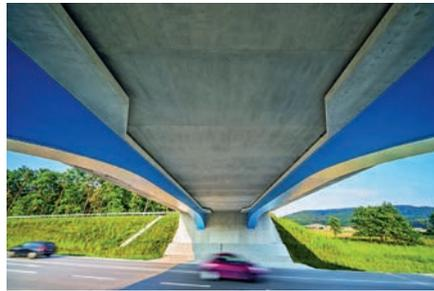
Bild 22. Brückenuntersicht mit VFT-Trägern und Fahrbahnplatte aus Segmenten (© Max Bögl)
