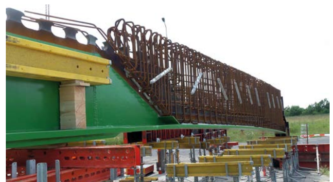
Bild 14. Bewehrung des Betonstegs vor dem Einschalen der Träger Fig. 14. Reinforcement cage of the concrete web before the formwork of the girder will be placed
