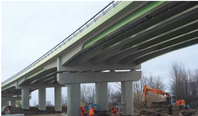
Bild 16. Brücke unter Verkehr Fig. 16. Bridge in service
