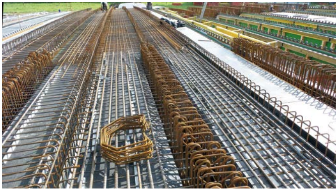
Bild 15. Feldfabrik für die Verbundfertigteilträger Fig. 15. Field factory for the prefabricated composite girders
